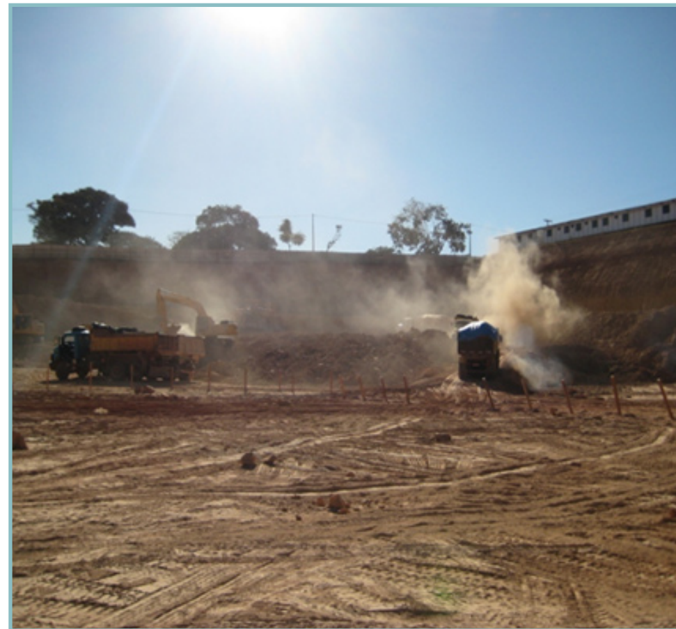
Foto 6 – Terraplenagem – Transporte, lançamento e espalhamento de material escavado
