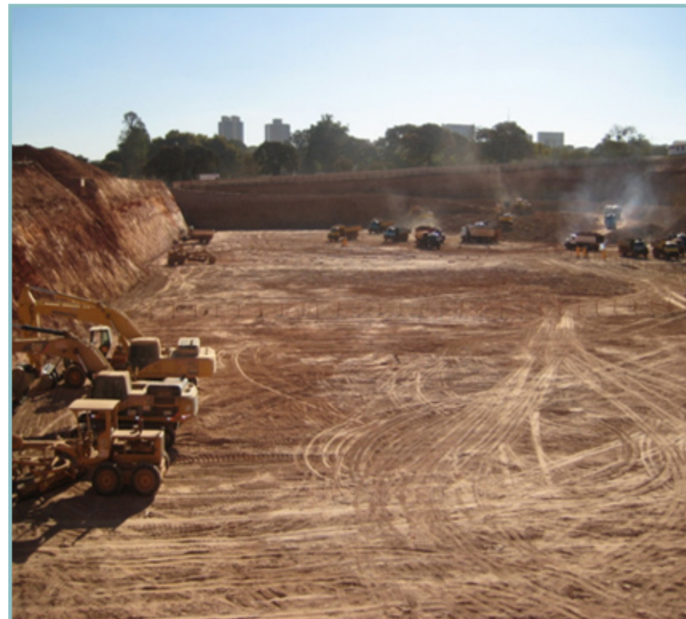
Foto 4 – Terraplenagem – Transporte, lançamento e espalhamento de material escavado
