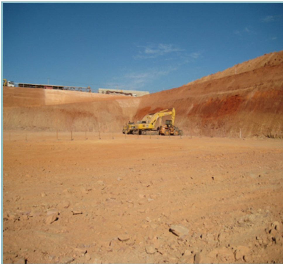
Foto 5 – Terraplenagem – Transporte, lançamento e espalhamento de material escavado
